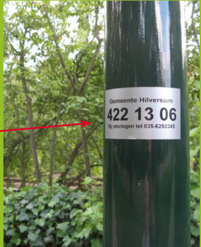
Als u belt dat de lamp stuk is, noteer dan het nummer en straat, te vinden op de mast.
